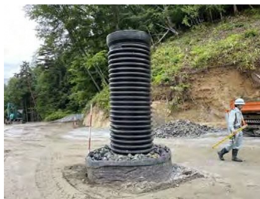
写真 2 水平排水工及び縦排水工の例
