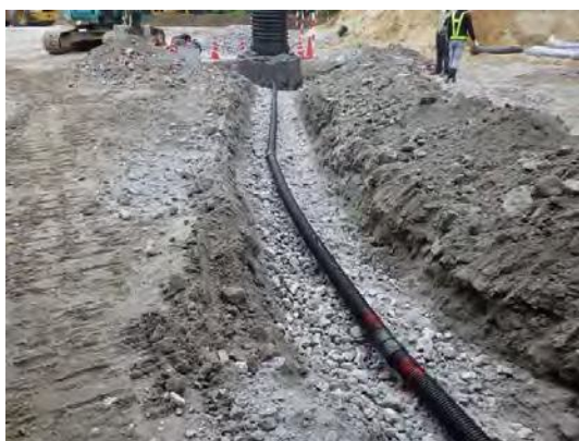
写真 2 水平排水工及び縦排水工の例
