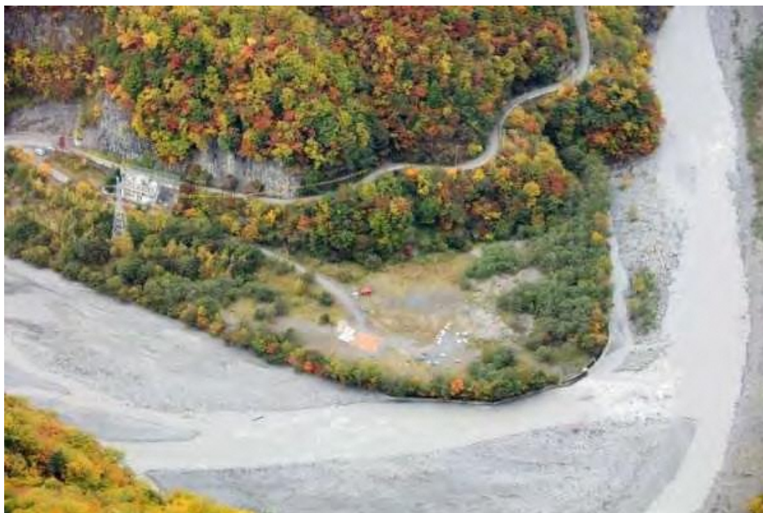
写真 5 剝石発生土置き場現地状況
