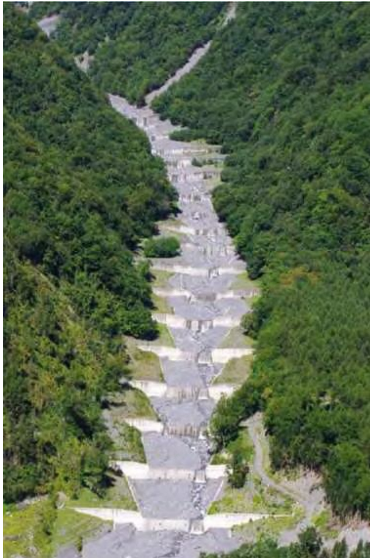
写真 6 上千枚沢の治山ダム
