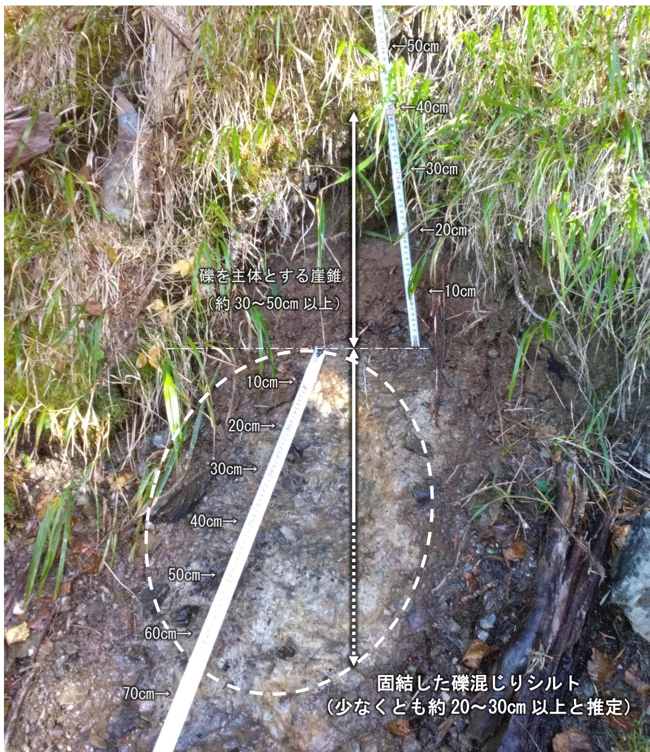
図 15 湧き水箇所の地質 (千枚小屋南側の湧き水)
