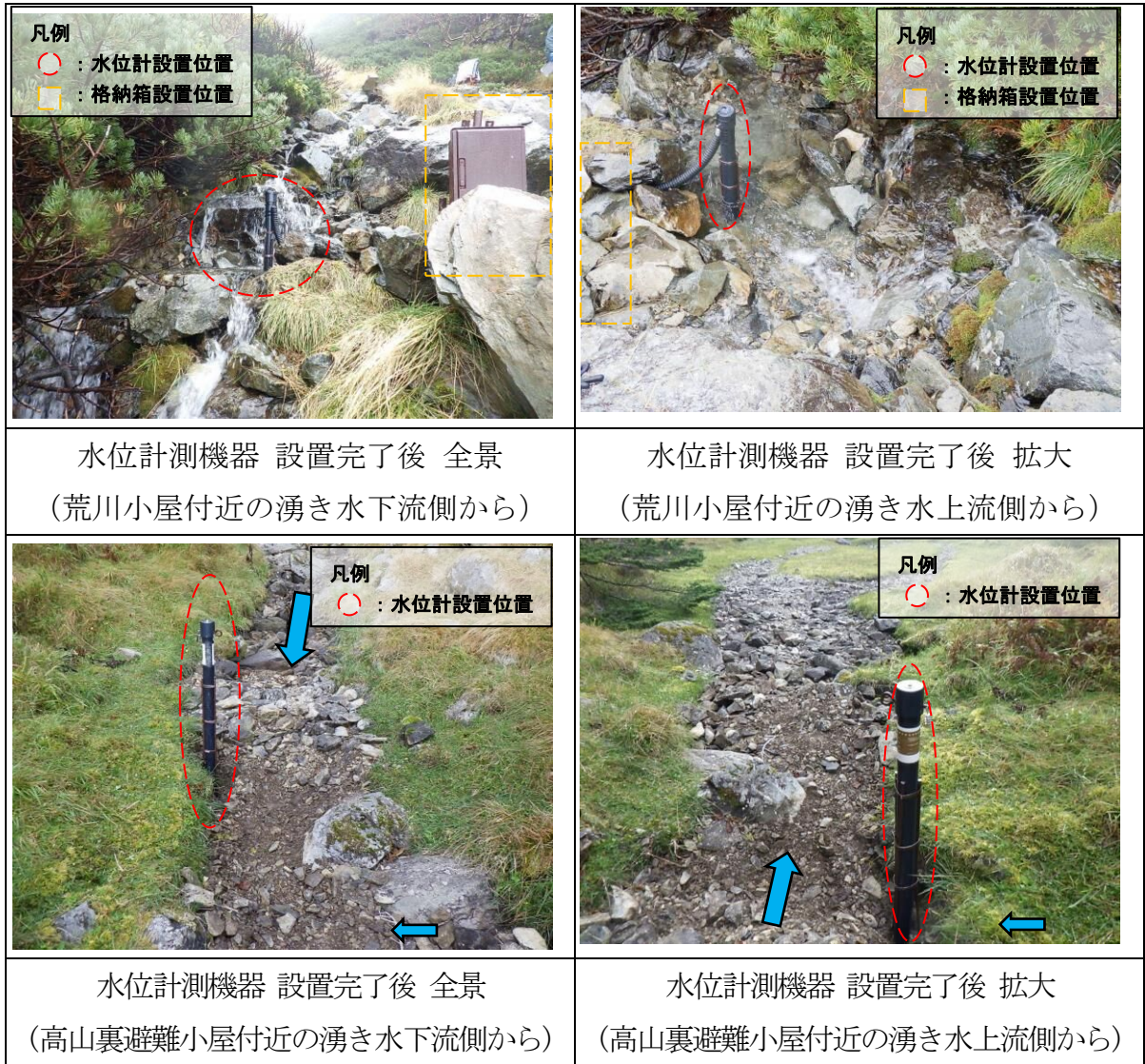
図 18 地表面付近の湧き水モニタリング (2/2)
