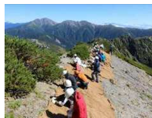
<南アルプスの自然> 塩見岳山頂付近(標高約3000m)での植生マット敷設>
