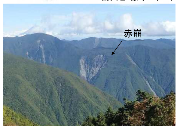
写真: 赤崩 崩壊地は拡大を続けている
