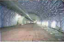
写真 防水シートの施工例
