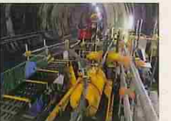
写真 施工状況
