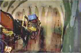
写真 薬液注入工の施工例
