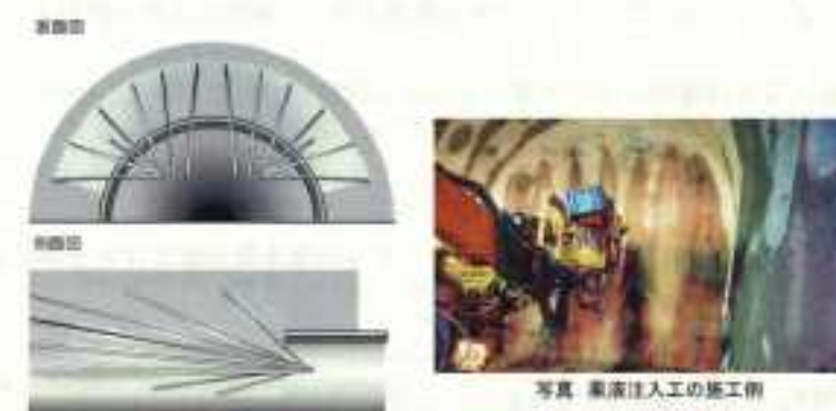
写真 薬液注入の施工例
