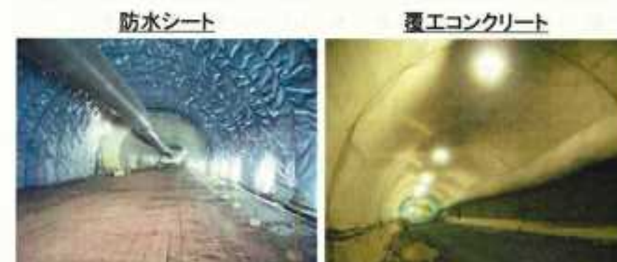
写真 防水シートの施工例 (一般国道191号線 基・三隅道路)
