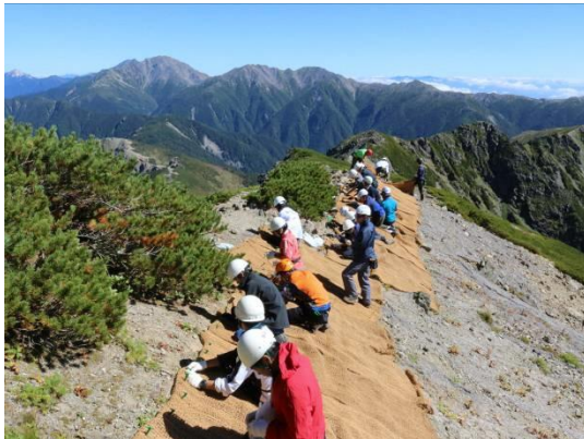
塩見岳山頂付近(標高約3000m)での植生マット敷設
