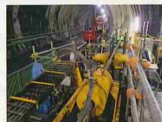
写真 施工状況
