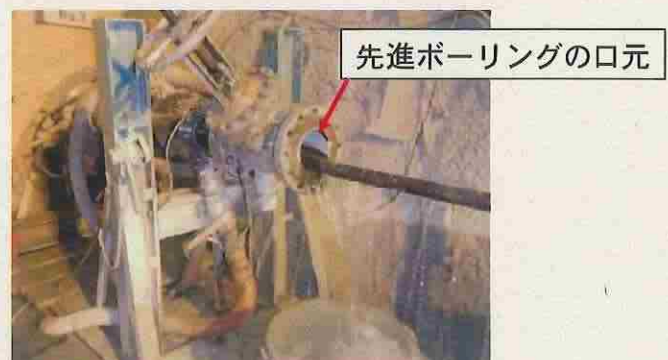
写真 先進ボーリング孔
