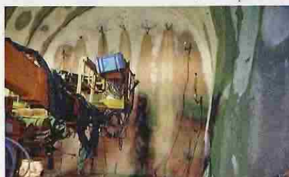
写真 地盤注入の例
