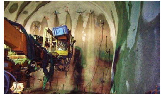
写真 薬液注入工の施工例
