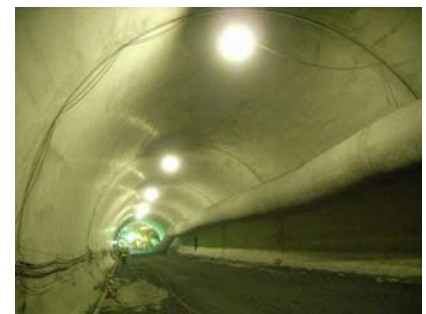
覆工コンクリートの施工例
