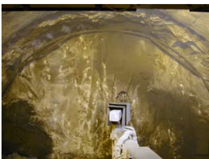
吹付コンクリートの施工例
