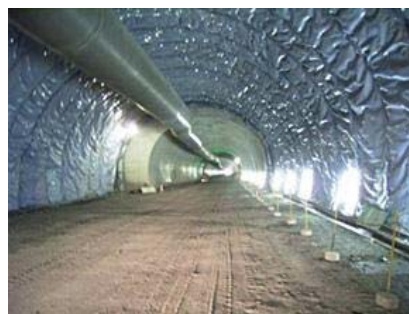
防水シートの施工例
