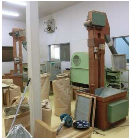
整備した仕上茶施設内部
