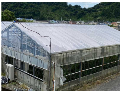
図1 遮熱剤塗布したハウス
