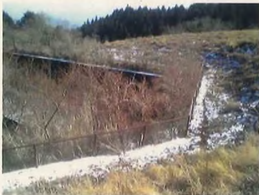
③ 調整池周辺のフェンス(安全対策)
