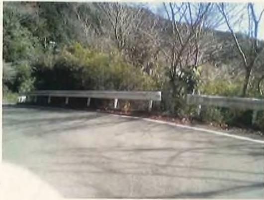
② 市道からの状況(右側が事業地)
