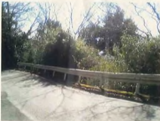
③ 市道からの状況(右側が事業地)
