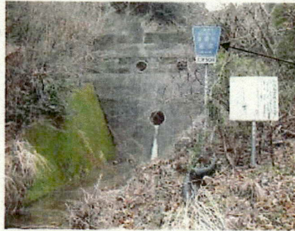
収去地点 (砂防ダム出口)
