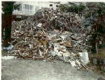
<解体現場> 上側入口
