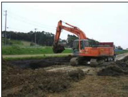
写真1 泥炭層の除去作業
