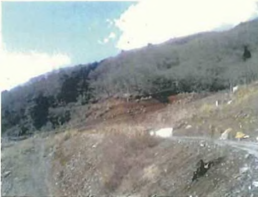
② 盛土法面の状況
