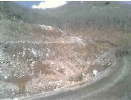
③ 掘削法面の状況
