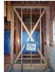
耐震補強工事(筋かい設置)
