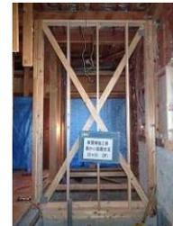
耐震補強工事(筋かい設置)
