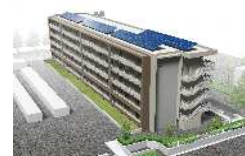
屋上に太陽光発電パネルを設置
