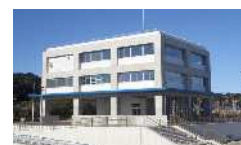
ZEB化県有建築物 (御前崎港管理事務所)
