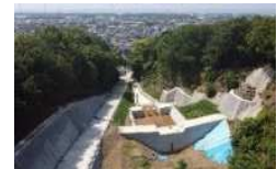
砂防堰堤の整備：掛川市大坂沢
