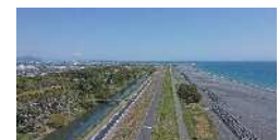
静岡モデル防潮堤 （吉田町川尻工区）
