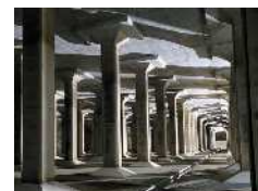
耐震化が完了した貯水池
