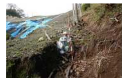
定期的な盛土点検実施
