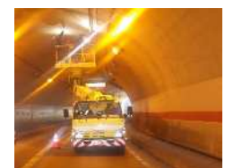
トンネル点検
