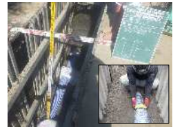
下水道管の整備
