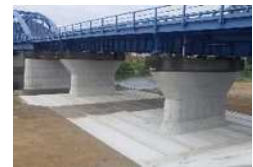
橋梁の橋脚補強工
