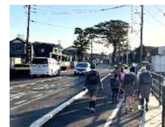
通学路の歩道整備
