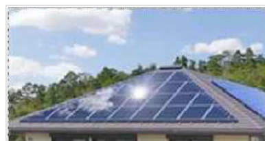
太陽光パネルの設置推進
