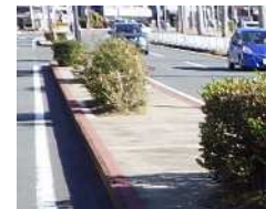
防草対策による通行空間の改善
