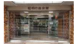
昭和の森シャッター交換
