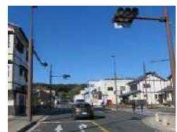
新居関所前の無電柱化
