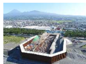
沼川新放水路防潮堤
