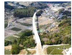
金谷御前崎連絡道路
