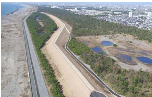
浜松市沿岸域防潮堤
