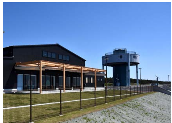
津波避難タワーと食の拠点「渚の交流館」
