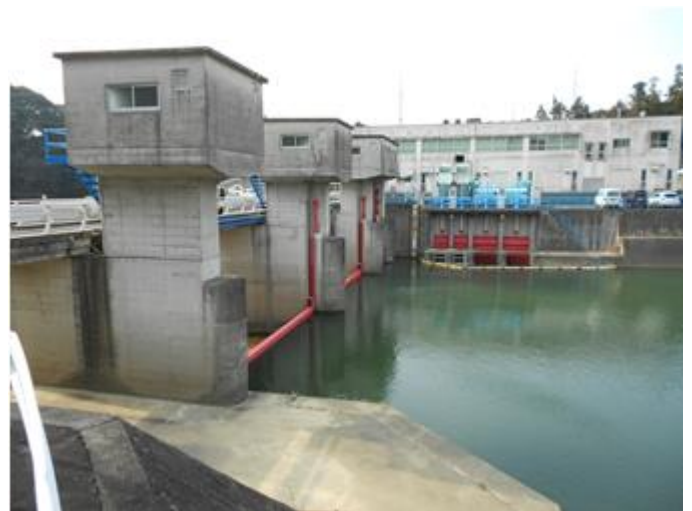
須部取水場（浜松市）
