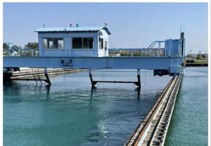
初生浄水場（浜松市）
