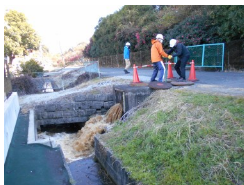
洗管(排水)作業中
