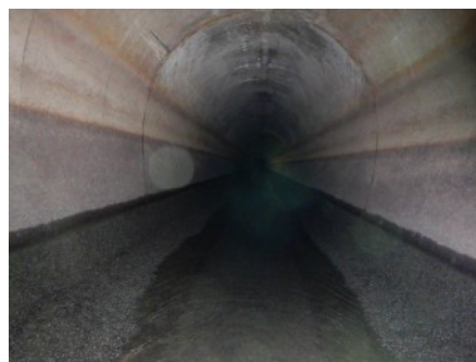
トンネルは馬蹄形のトンネルです。
