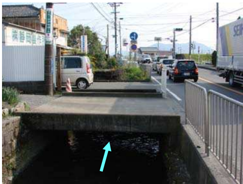
図 2-3 一般県道大川静岡線並走区間の河川の状況
