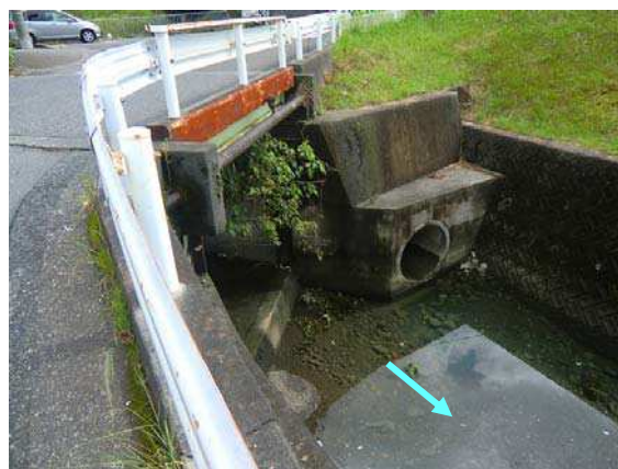
伝馬町樋管下流側(0.3k 付近)
