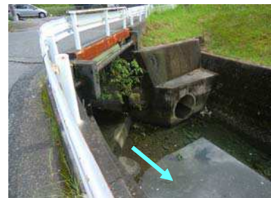
伝馬町樋管下流側
