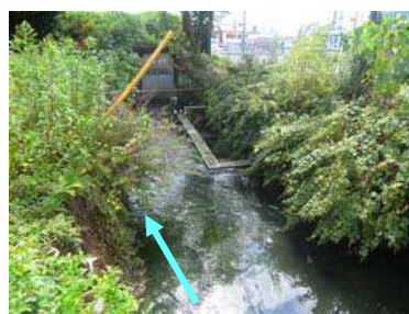
伝馬町樋管上流側
