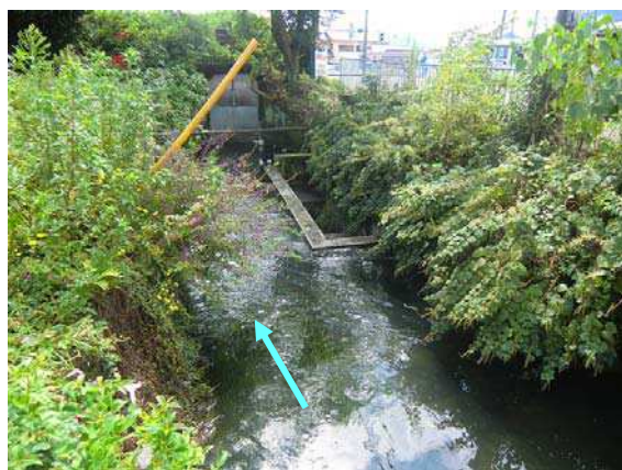
伝馬町樋管上流側(0.3k 付近)
