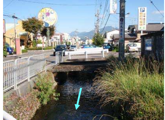
図 2-10 中流部の風景 (一般県道大川静岡線付近)
