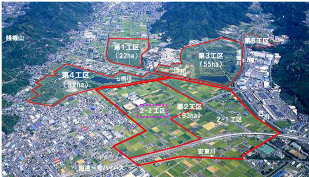
图 5.6 麻機遊水地 2-2 工区整備箇所
