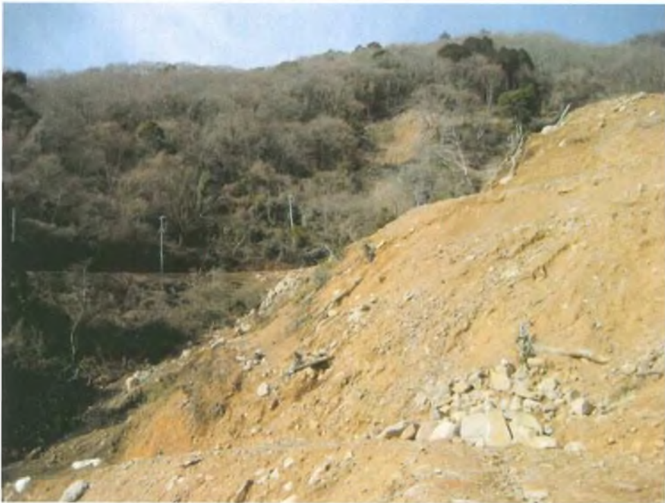
区域中央から上流側（中央部の道路は、市の水道施設管理道）
