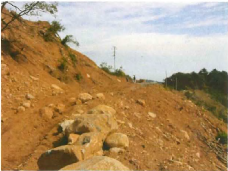
②市水道施設管理道
