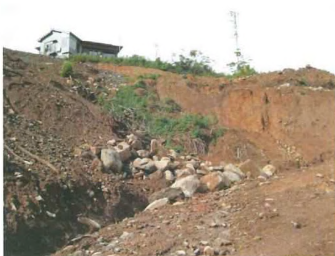
進入路の状況
