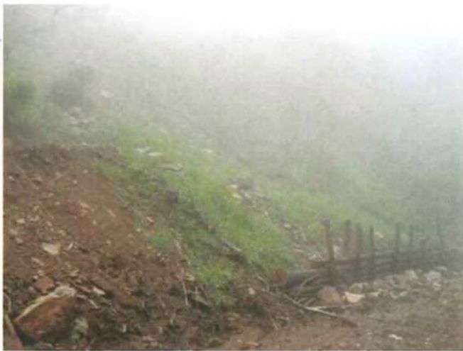
法尻 丸太柵 緑化状況
