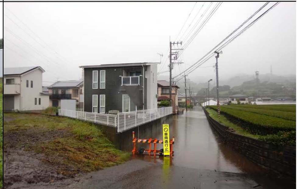
④江尾江川左岸の浸水状況
