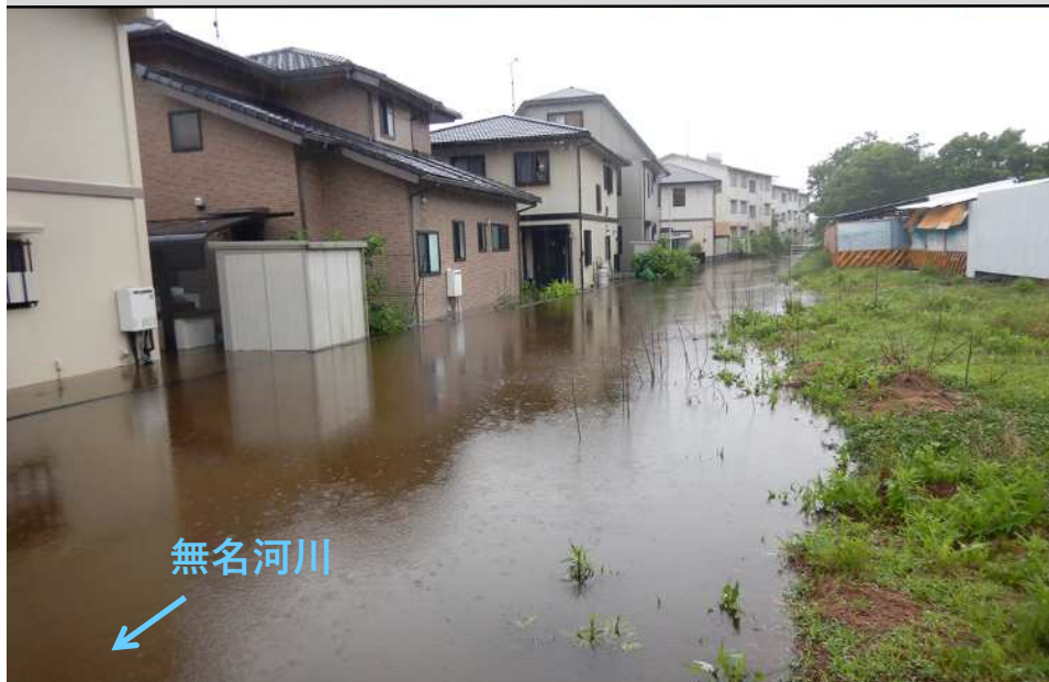
③江尾江川右岸の浸水状況
