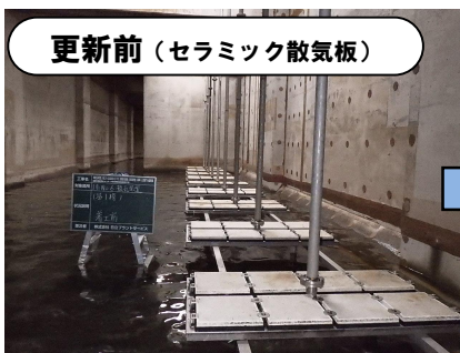
散気装置（汚水中に空気を送り込み微生物の働きにより汚水を処理（上記写真））
