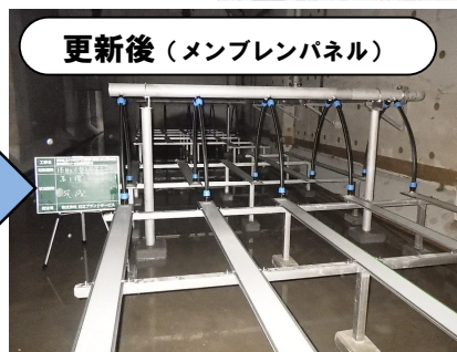
散気装置（汚水中に空気を送り込み微生物の働きにより汚水を処理（上記写真））
