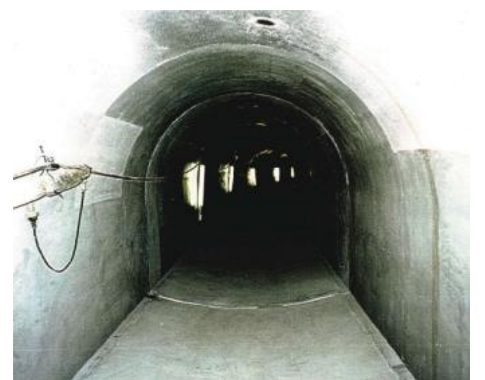
1998年補修当時の隧道（コンクリート巻立て）
