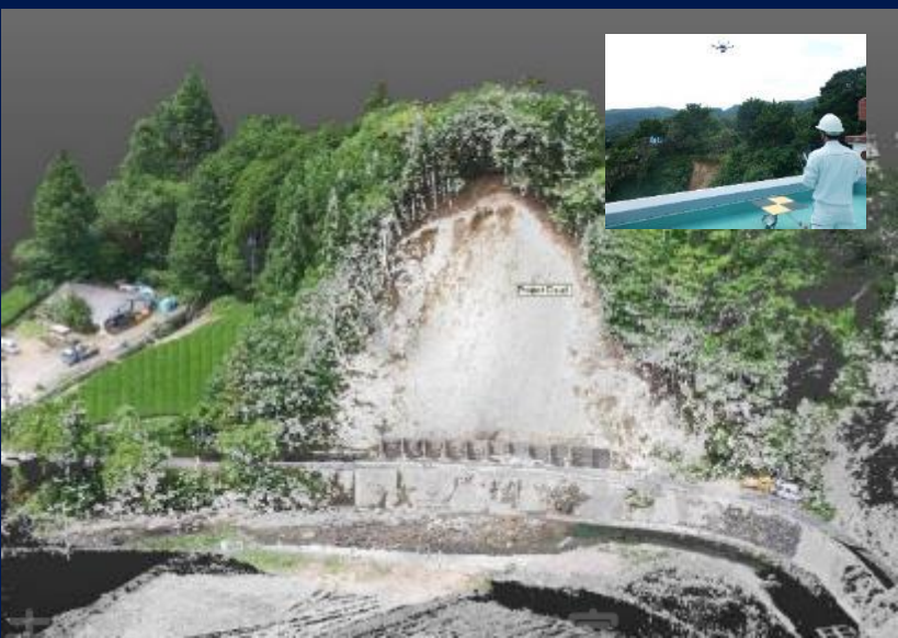
被災後に3次元点群データ計測
