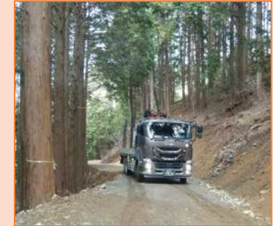
<基幹的作業道〔浜松市天竜区〕>
