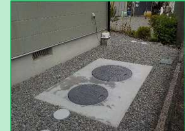
合併浄化槽の設置
