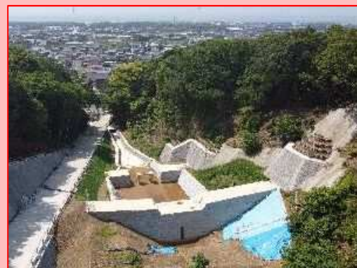
砂防堰堤の整備
