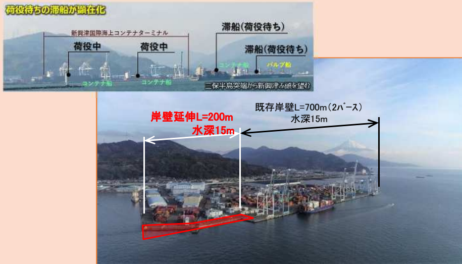
船舶の増加・大型化に対応した施設整備 (清水港新興津岸壁の延伸、ふ頭用地整備) ＜清水港〔静岡市清水区〕＞
