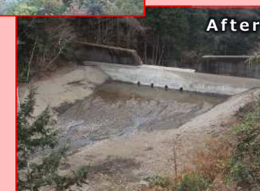
砂防堰堤の除石
