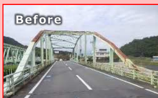
橋梁の長寿命化対策 ＜葛蒲橋〔伊豆の国市〕＞
