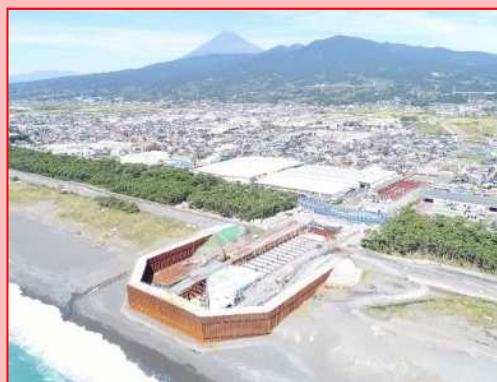
放水路の整備
