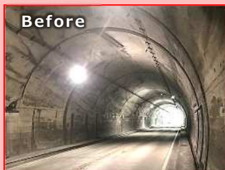
トンネルの長寿命化対策 ＜奥野トンネル〔伊東市〕＞
