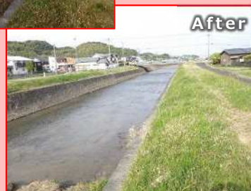
堆積土砂の掘削
