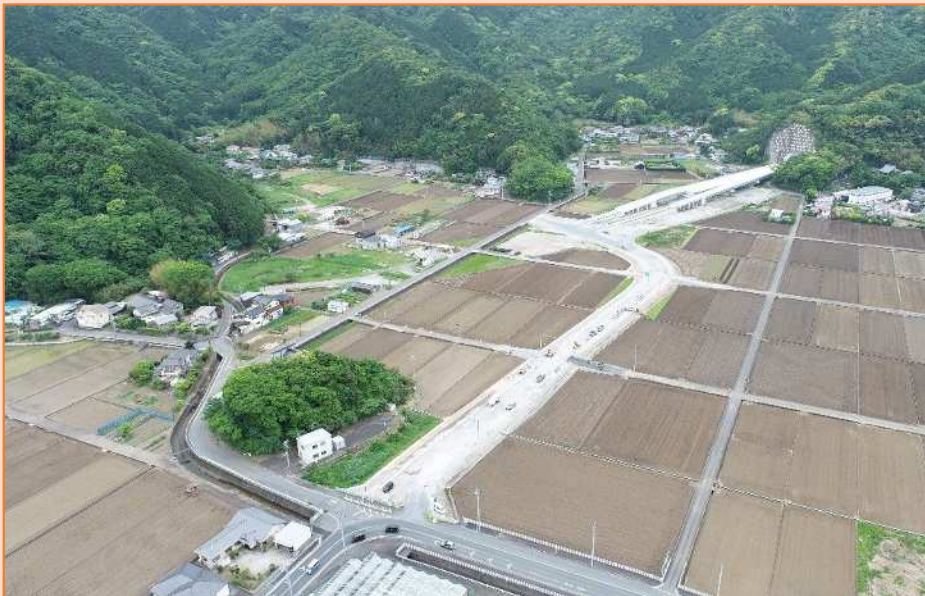
<国道414号（静岡バイパス）〔沼津市〕>
