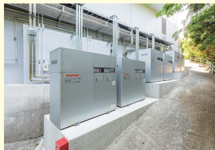
ホテルアンピア松風閣のコージェネレーションシステム
