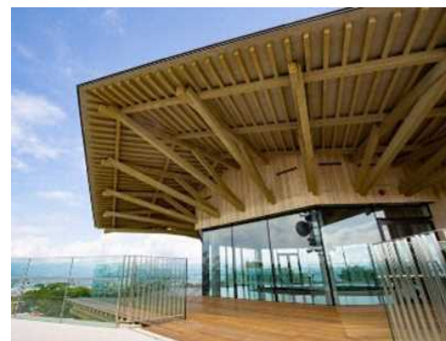
県有建築物における 県産材による木造化
