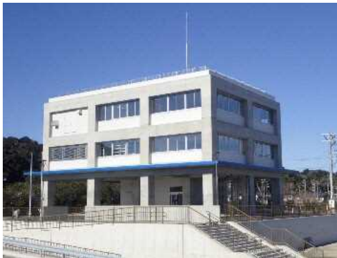
県有建築物のZEB化
