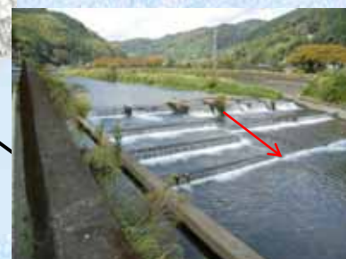
河津川下流（取水堰）
