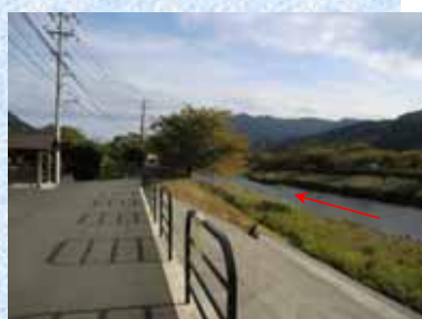
左岸2.2k付近 階段護岸
