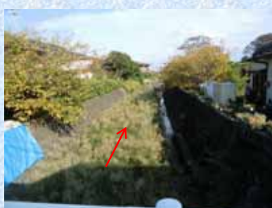
河津谷津川（迦堂橋）
