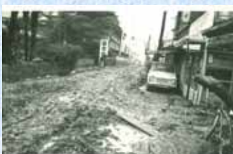
昭和33年9月(狩野川台風) 河津町峰付近の被災状況(河津川)
