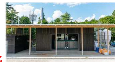
地域材を活用した木質バイオマス発電所（小山町）
