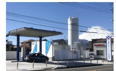
水素ステーション御殿場
