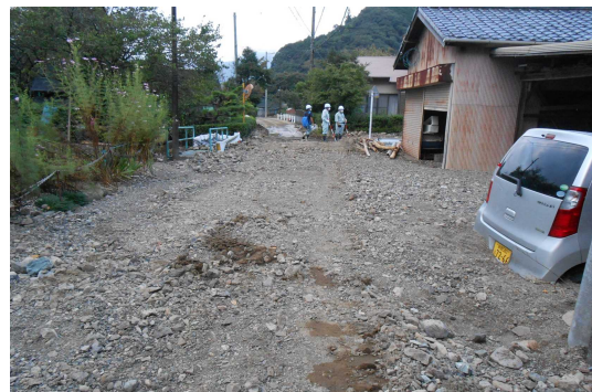
下流被害状況 (静岡市葵区牛妻)
