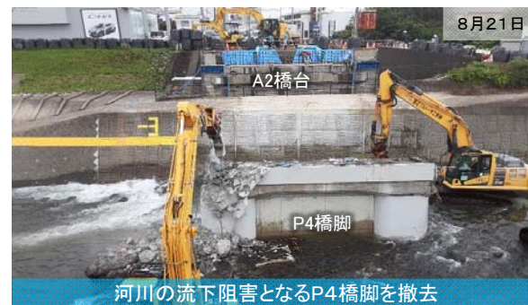
河川の流下阻害となるP4橋脚を撤去
