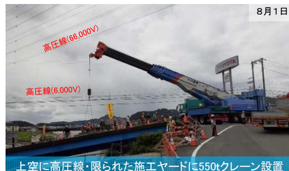
上空に高圧線・限られた施工ヤードに550tクレーン設置
