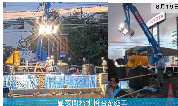
昼夜問わず橋台を施工
