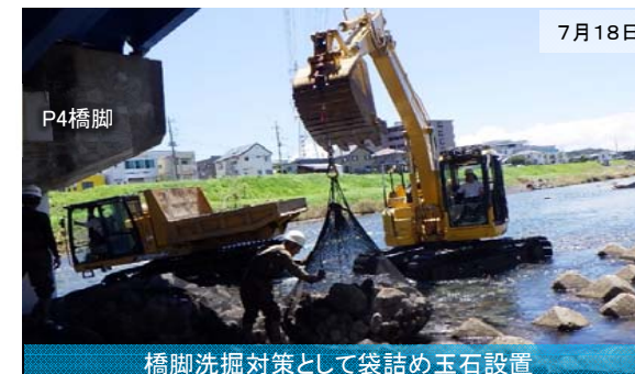
橋脚洗掘対策として袋詰め玉石設置
