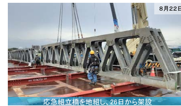
応急組立橋を地組し、26日から架設
