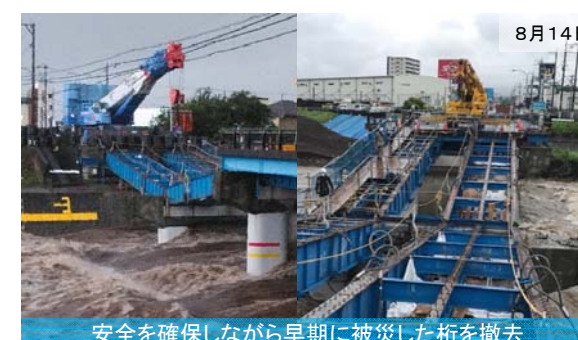
安全を確保しながら早期に被災した桁を撤去
