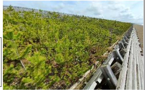
海岸防災林造成状況
