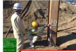
硬質地盤による鋼矢板打設不能を確認
