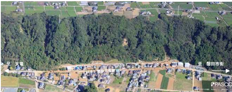
■被災状況①(磐田市平松) 全景
