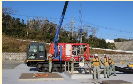
可搬型注水設備操作訓練
