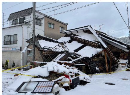
市街地建物被害状況
