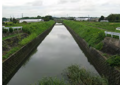
図- 1.3.7 内張川高潮対策区間の状況
