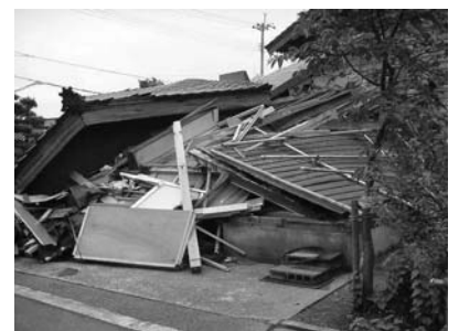
（平成19年 新潟県中越沖地震より）
