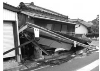
(平成19年 新潟県中越沖地震の被害)
