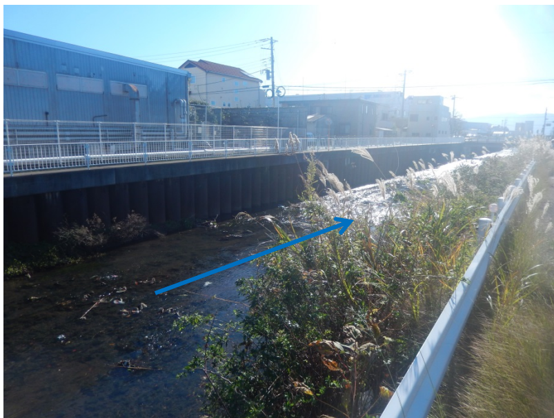
新中川 沼津市沢田 明電舎横付近
