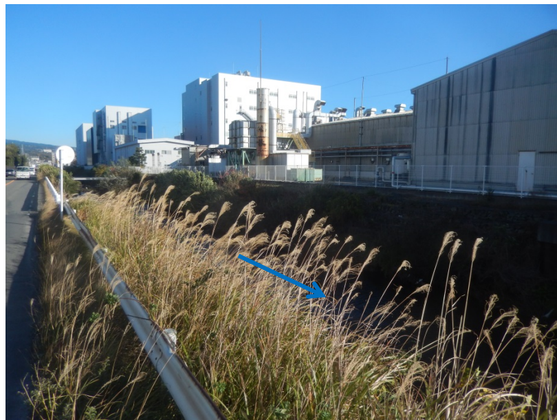
新中川 沼津市沢田 明電舎横付近
