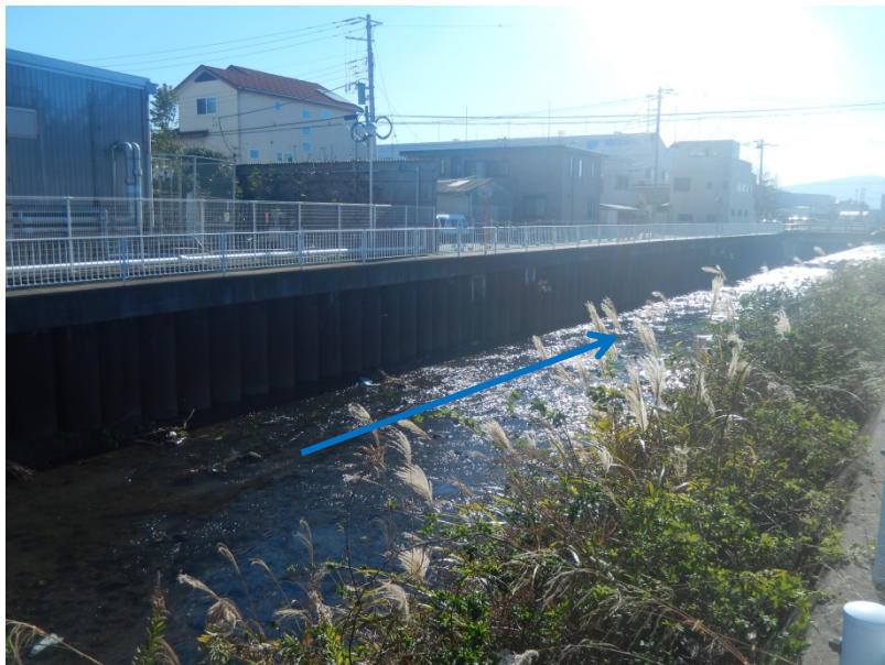
新中川 沼津市沢田 明電舎横付近
