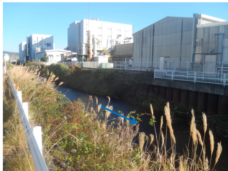
新中川 沼津市沢田 明電舎横付近
