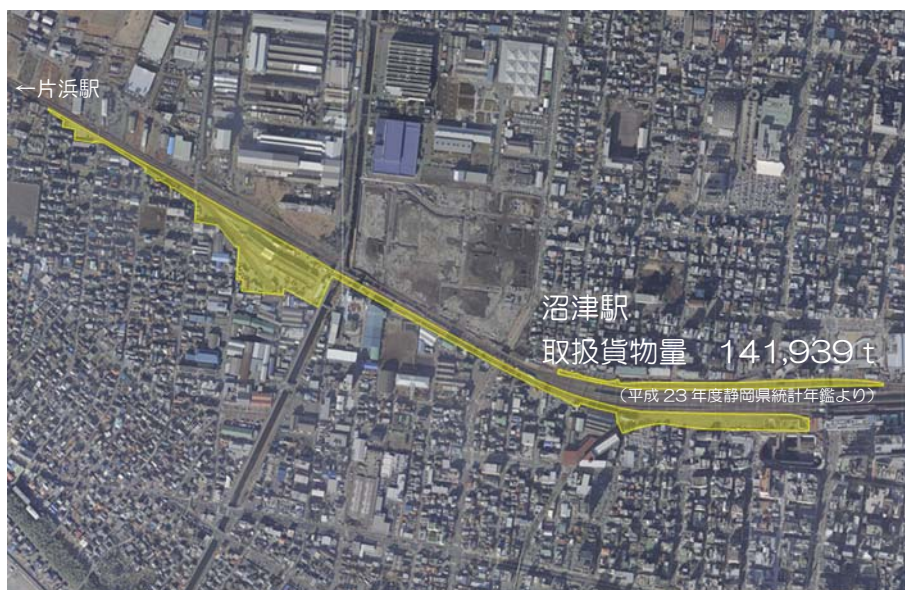
図：現在の貨物駅の状況
