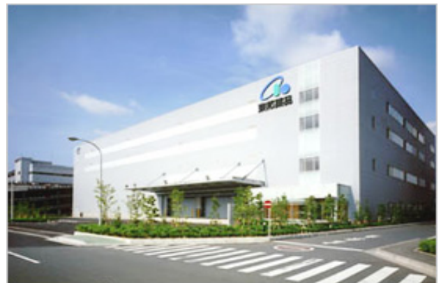
東京貨物ターミナル駅《エフ・プラザ東京 E 棟》 【東邦薬品株】
