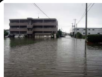
平成20年7月4日洪水 沼津市青野地区
