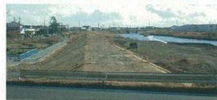
河川堤防工事中の芳川
