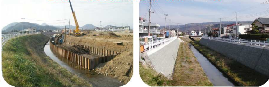
古川橋～上中橋区間の河道改修（平成16～25年）
